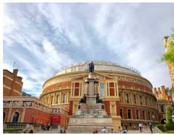
ロイヤル・アルバート・ホール
